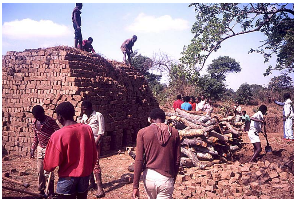
Alumnos de la escuela Kidugala apilando ladrillos que ellos mismos habían realizado.
